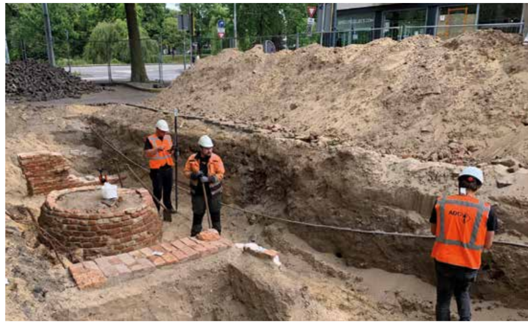
Funderingen en een beerput gebouwd na de demping van de grachten (vanaf de vroege 19e eeuw)
